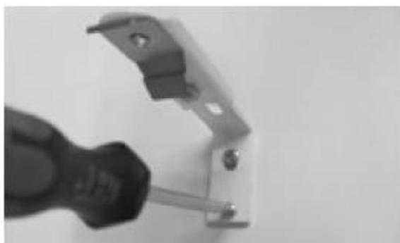
Wandwinkel montieren und Schiene von unten einklicken – Der Träger ist für die Montage von einer 2- bzw. 3-Lauf-Schiene ausgelegt.
