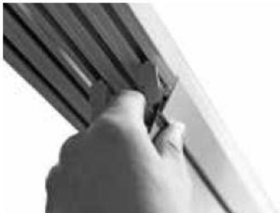
Paneel mit Behang leicht schräg von unten am Paneelwagen ansetzen
